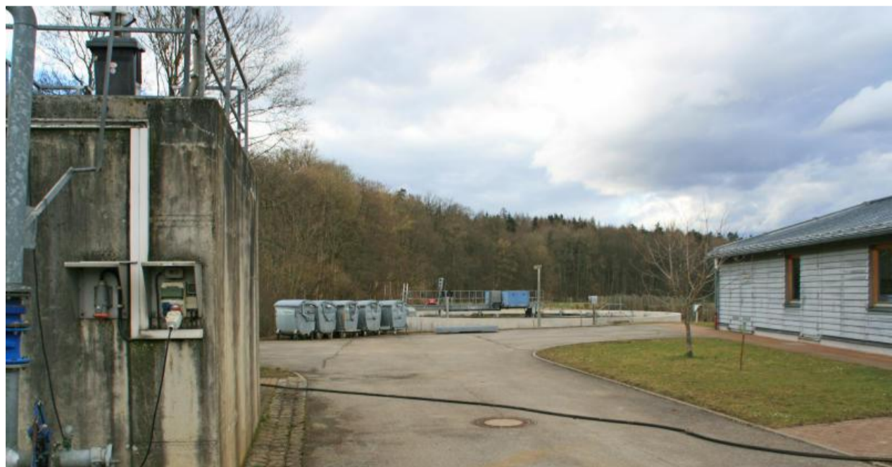
Die Sanierung der Engelthaler Kläranlage ist erst ab 2017 geplant.
